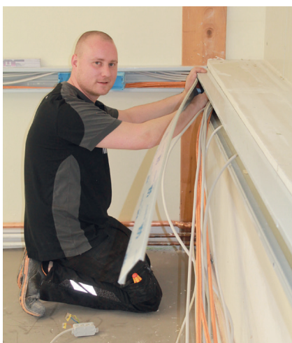
Karsten Meder beim Verlegen von Leitungen
